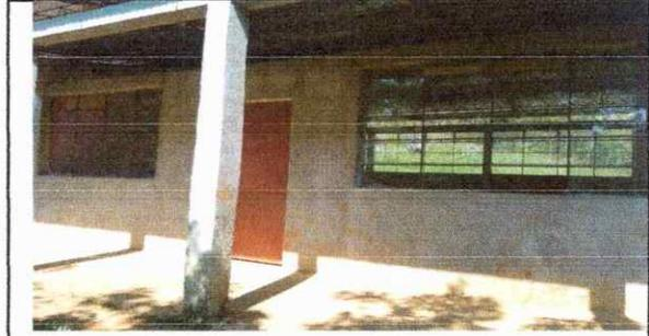
Foto1: Aula 1. Primero, Segundo, Tercero. Sustitucion de vidrios y estructura de techo
